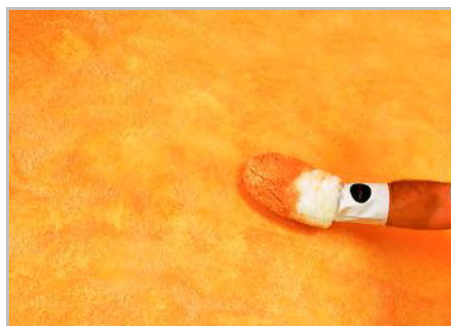
Fase 6 - Seconda mano, opzionale se si desidera 'invecchiare' il muro, ripassare dopo 15/30 minuti con il guanto inumidito di prodotto
