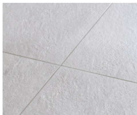
Pavimentazione stuccata con Keracolor GG
