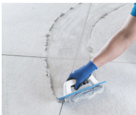
Stesura di Keracolor GG con spatola MAPEI
